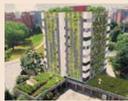
Verde in facciata e sul tetto. Come sarà l'edificio di via Russoli a Milano dopo l'intervento di riqualificazione
